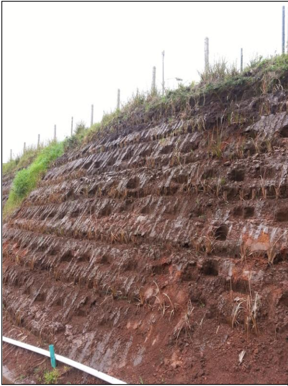
Fotos 2 y 3. Detalle de la siembra de vetiver en el talud, y su bajo desarrollo.
