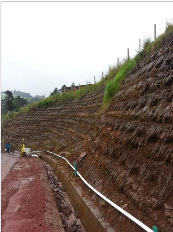
Foto 1. Vista General del Talud con vetiver
