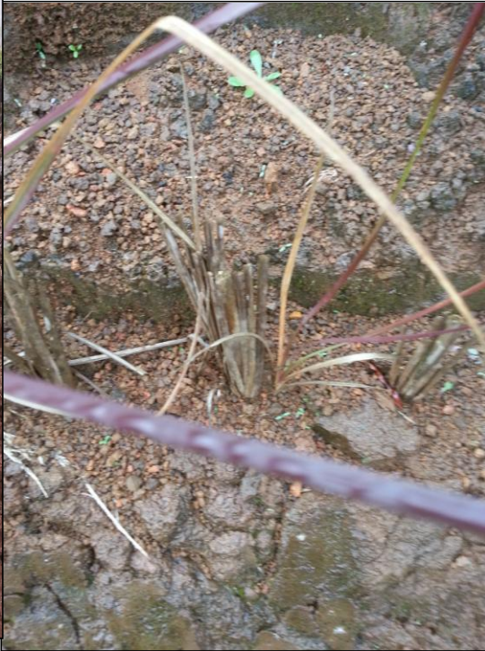
Fotos 2 y 3. Detalle de la siembra de vetiver en el talud, y su bajo desarrollo.
